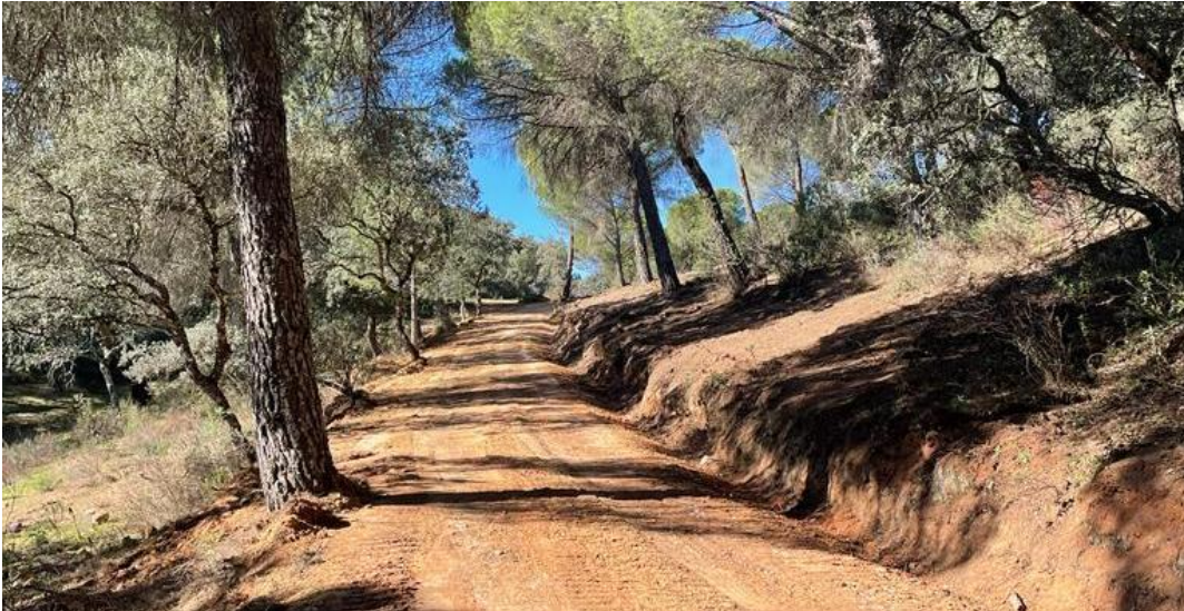
Figura 9. Miglioramento della strada di campagna a La Tejera. La pavimentazione stradale può essere facilmente compattata con una trave pesante. I fossati dovrebbero essere puliti nelle aree di deflusso vicino ai focolai e/o alle aree fortemente colpite, incanalando il deflusso verso i principali corsi d'acqua.
