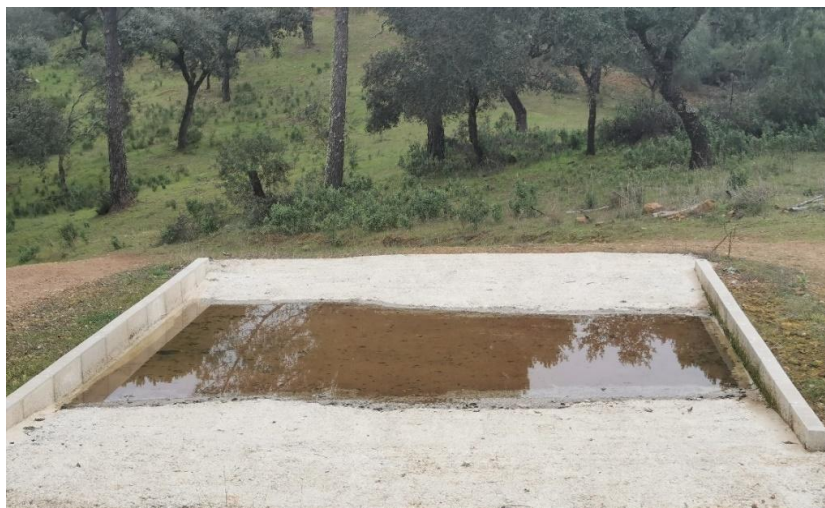
Figura 11: Ejemplo de estación de limpieza de vehículos en la entrada principal de una finca.
