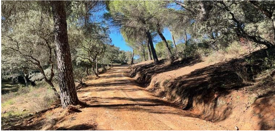
Figure 9: Melhoria de estradas rurais em La Tejera, O revestimento das estradas pode ser facilmente compactado com uma viga pesada. Devem ser limpas as valas nas zonas de escoamento próximas dos focos e/ou zonas fortemente afectadas, canalizando o escoamento para os cursos de água principais.
